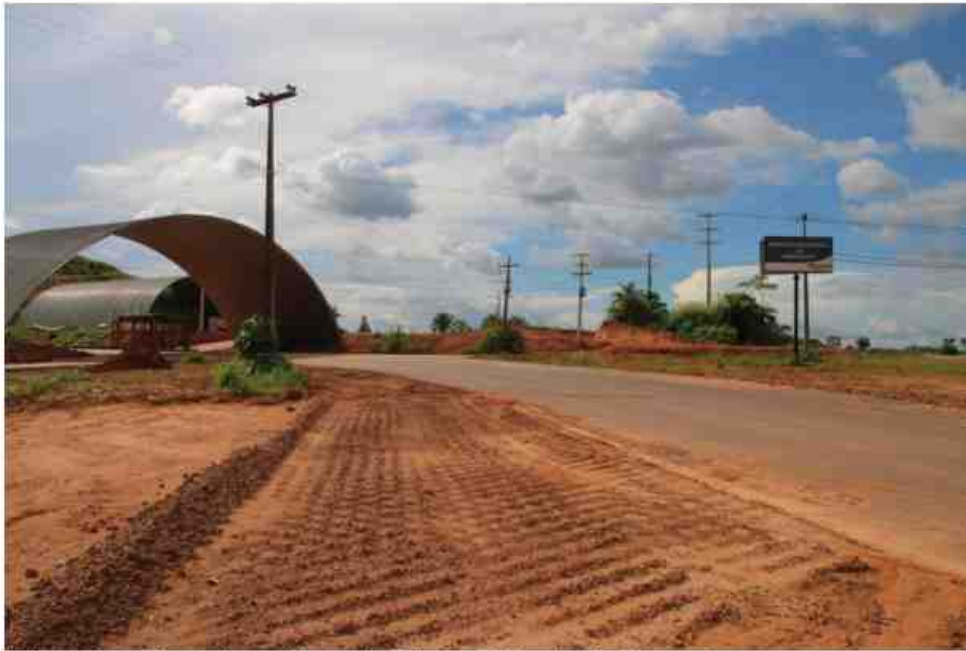
Figura 18 - Obras de ampliação do Distrito Industrial de Imperatriz. Fonte: Jackson Silva / Sinfra
