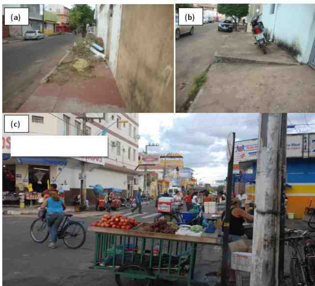
Figura 42 - (a), (b) e (c) Usos inapropriados das calçadas (espaço público). Fonte: Izadora Santos, 2014 (Prefeitura de Imperatriz-MA)
