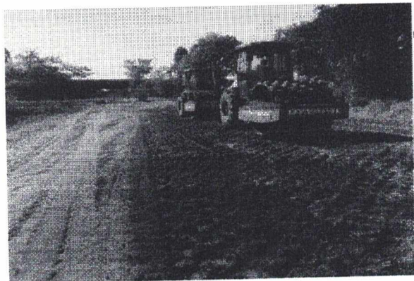
Máquinas trabalham na obra
