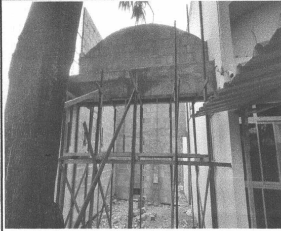
LEVANTE DE PAREDES DE ALVENARIA E ESTRUTURA DE CONCRETO
