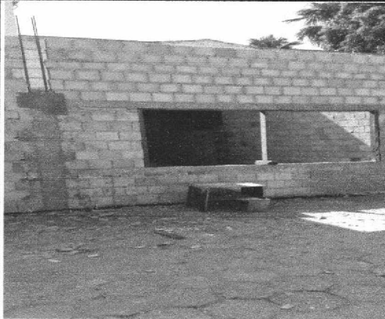
EXECUÇÃO DE PILARES EM CONCRETO ARMADO
