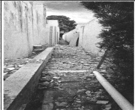
SERVIÇOS DE DEMOLIÇÃO E RETIRADA DE ENTULHO
