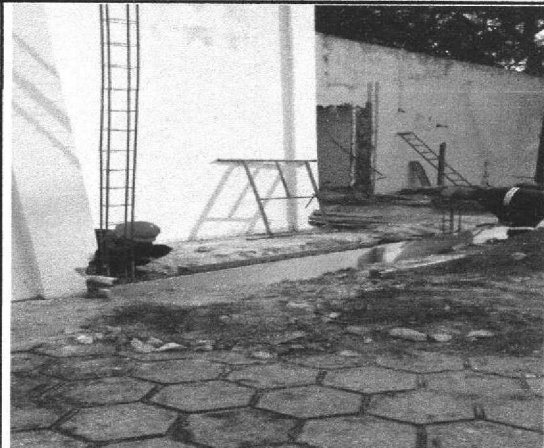
EXECUÇÃO DE VIGA BALDRAME EM CONCRETO ARMADO
