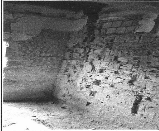
SERVIÇOS DE DEMOLIÇÃO E RETIRADA DE ENTULHO
