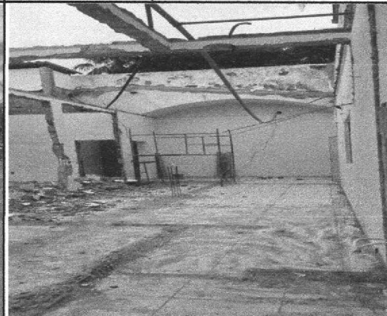
SERVIÇOS DE DEMOLIÇÃO E RETIRADA DE ENTULHO
