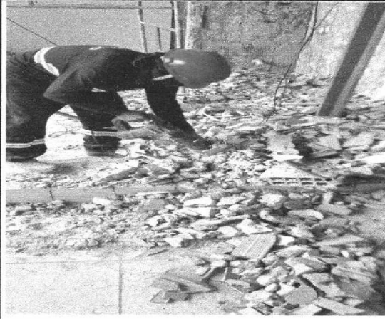
SERVIÇOS DE DEMOLIÇÃO E RETIRADA DE ENTULHO
