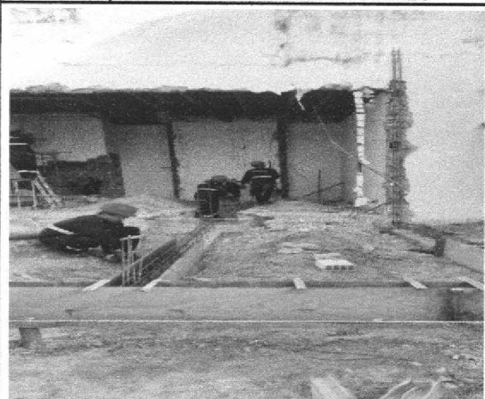
EXECUÇÃO DE VIGA BALDRAME EM CONCRETO ARMADO
